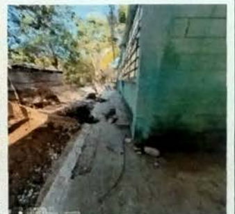
Foto 6: TRABAJOS EXTERIORES Proceso de elaboracion de muro perimetral de block, etapa de trazo y retiro de material existente.
