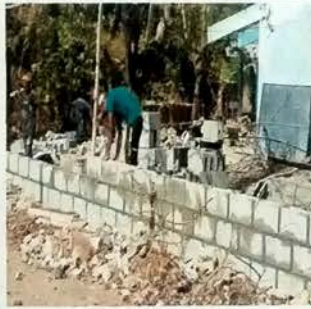
Foto 3: TRABAJOS EXTERIORES Proceso de levantado de block pomez.
