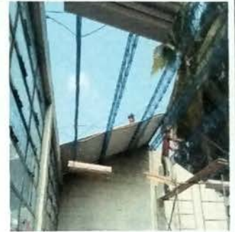
Foto 2: MODULO A Proceso de desmontaje de lamina existente en mal estado.
