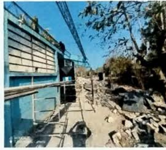
Foto 4: MODULO A VISTA LATERAL Proceso de desmontaje de lamina existente en mal estado para posterior darle mantenimiento a los Joist de metal.
