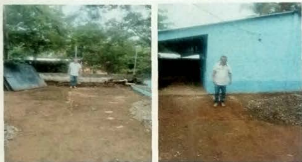
Foto 7: VISTA FRONTAL DE MODULO A DE AULA.
