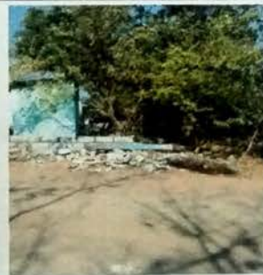
Foto 5: TRABAJOS EXTERIORES Proceso de elaboracion de muro perimetral de block, etapa de trazo y retiro de material existente.
