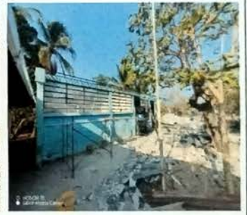
Foto 4: MODULO A VISTA LATERAL Proceso de desmontaje de lamina existente en mal estado para posterior darle mantenimiento a los Joist de metal.
