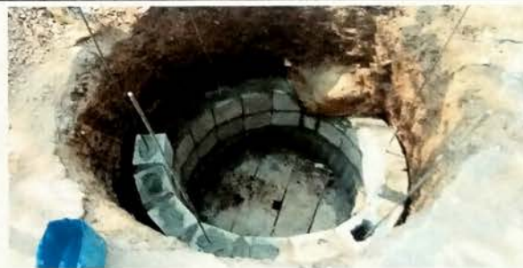
Foto 10: TRABAJOS EXTERIORES Vista de conformacion de brocal para pozo para extraccion de agua potable.
