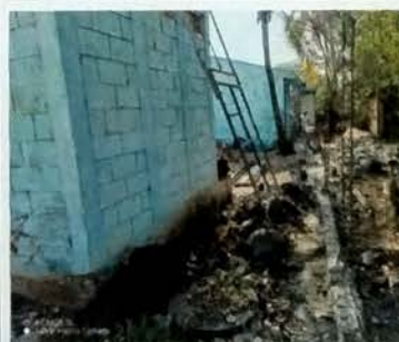
Foto 6: TRABAJOS EXTERIORES Proceso de elaboracion de muro perimetral de block, etapa de trazo y retiro de material existente.
