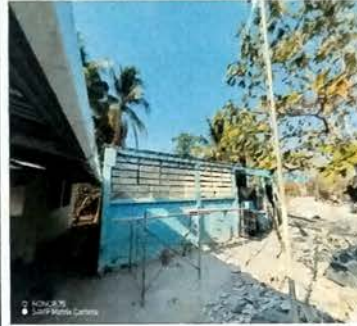
Foto 2: MODULO A Proceso de desmontaje de lamina existente en mal estado.
